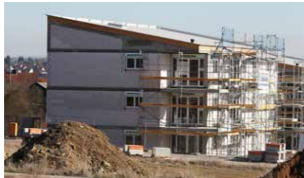
Die beiden Mehrfamilienhäuser an der Heinrich-Böll-Straße mit 18 Wohnungen werden bis Juli fertiggestellt. Acht Reihenhäuser sind bereits fertig (Bild oben).
