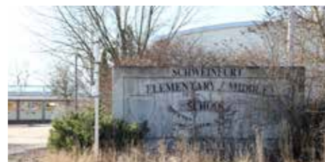
An der Stelle der ehemaligen amerikanischen „Schweinfurt Elementary Middle School“ wird nach deren Abriss eine neue Grundschule samt Hort, Kindertagesstätte und Turnhalle entstehen. © Stefan Pfister
