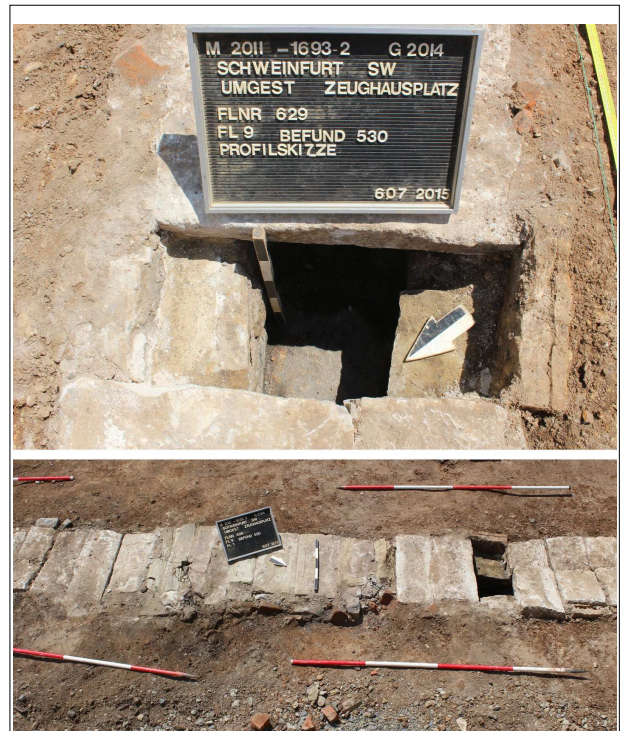
Abb. 31: Schweinfurt. Umgestaltung Zeughausplatz. Oben: Innenansicht Kanal Bef.-Nr. 530. Unten:
